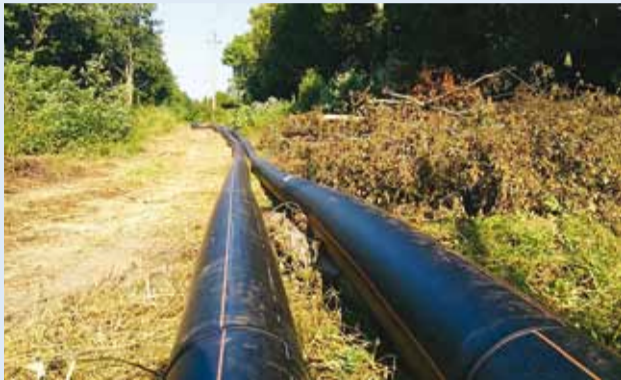
Raudtee ääres ootab maasse paigaldamist reovee survetorustik. Foto Lauri Lagle
