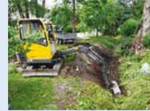
Hallikivi tee sademeveetööd. Foto Taavi Valgmäe
