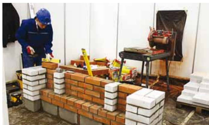
Müürsepa õppiv Valeri Ivanov ehitab sokliga tellismüüritist. Foto Sandra Sarv
