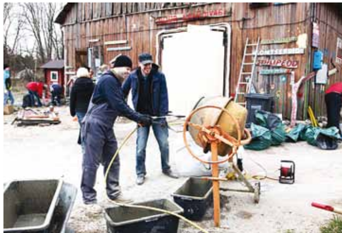
Timmo Aleksandrov ja Alar Mik valmistasid sadamakuuri põrandaparandamiseks betooni.
