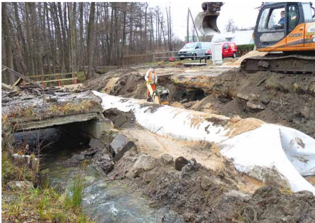
Ojakääru silla rekonstrueerimine.
