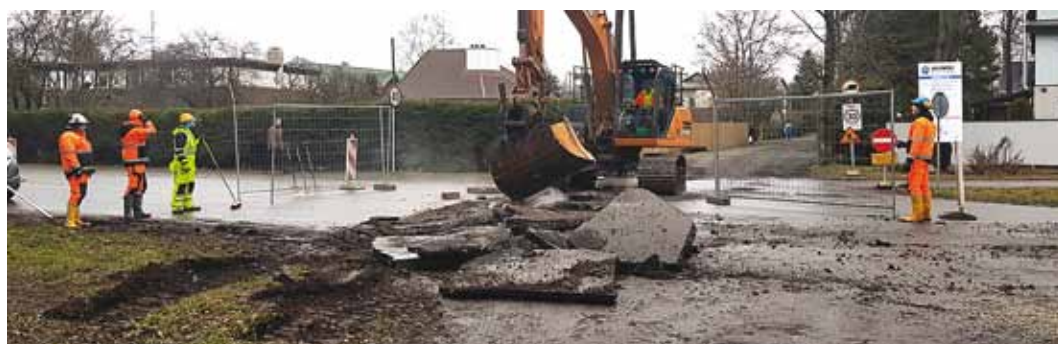
Sademeveekollektori ehitus Rohuneeme tee ja Männi tee ristmikul. Foto Taavi Valgmäe
