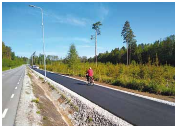
Radarjuhtimissüsteemiga LED-valgustus Randvere tee ääres. Foto Taavi Valgmäe
