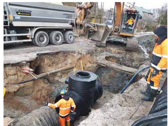
Tammepõllu ja Männi tee sademeveekollektori ehitus. Foto Taavi Valgmäe
