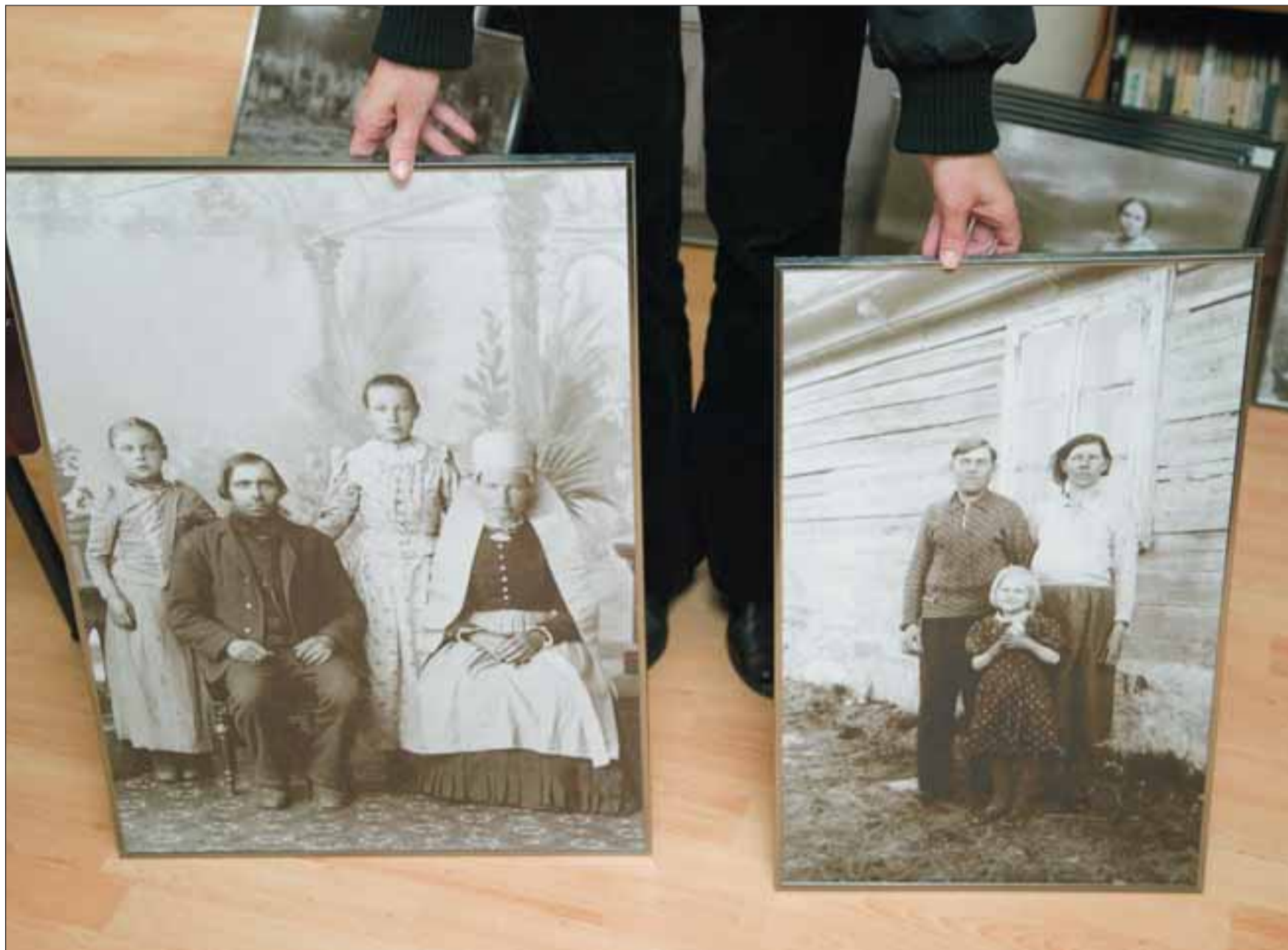
Kaks näitusefotot – vasakpoolsel on jõukal järjel, parempoolsel fotol lihtne perekond. Rikka perekonna pea oli Maardu vallavanem Hermann Tagaväli ning see ateljeefoto on tehtud 1880. aastate lõpus. Teine pilt on tehtud taluüuel ning pildil on lihtne kaluripere Leppneemest. Pereisa nimi oli Aleksander Karjaherm.
