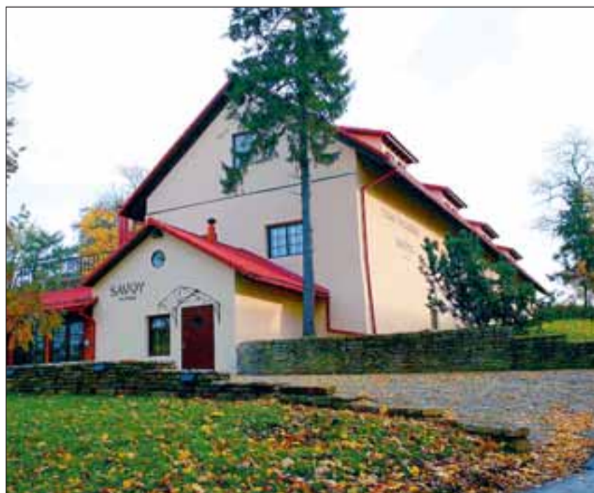
Peokeskus ulatub läbi kolme korruse – esimesel on restoran, teisel peokeskus ning kolmandal, pealeehitatud korrusel paikneb hotell.
