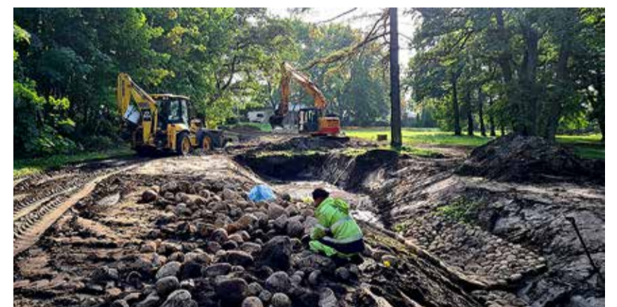
Säästlik sademeveelahendus vaba aja veetmise alana roheala koosseisus, sh sademevee viivitus, puhvertiik, vee setteala, istetalade rajamine, taimestik. Foto: Alar Mik
