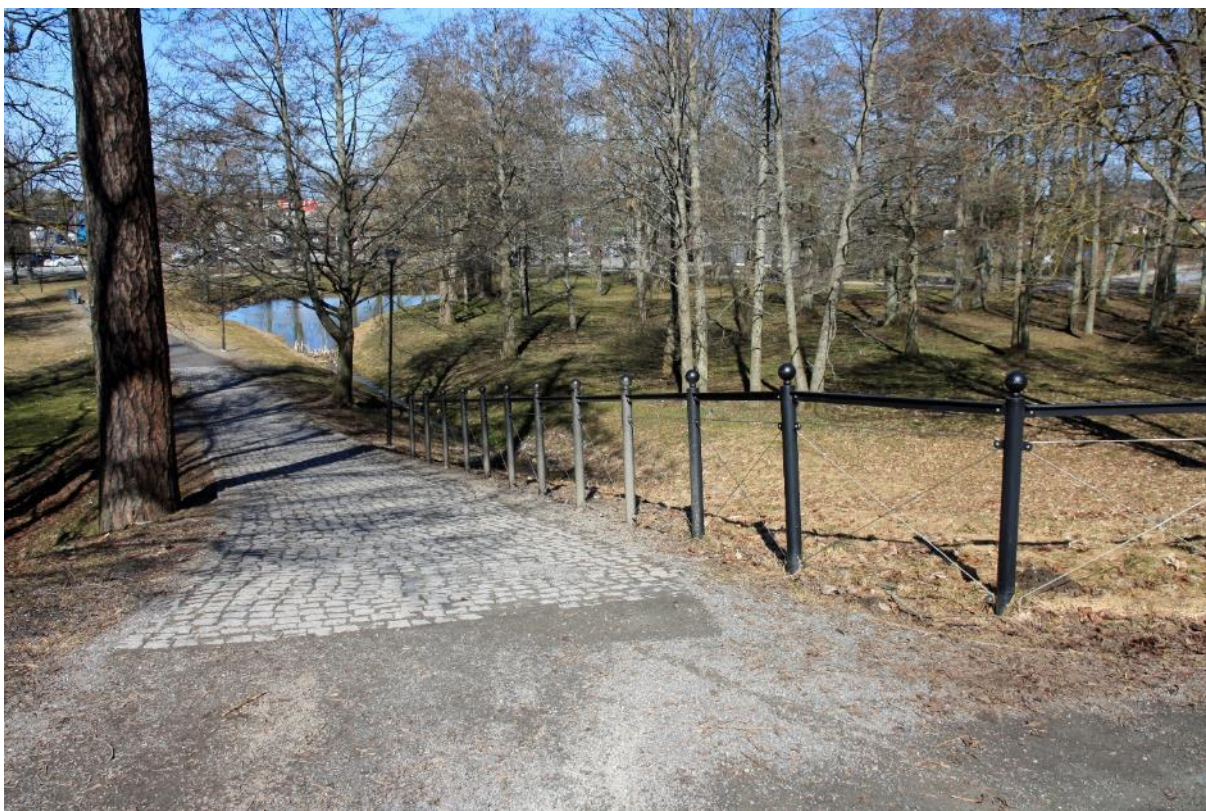
7. Mõisapargi tee ja Maria Laidoneri tee ristumiskoht, vaade alumisele tiigile ja tee ääres olevale piirdele.
