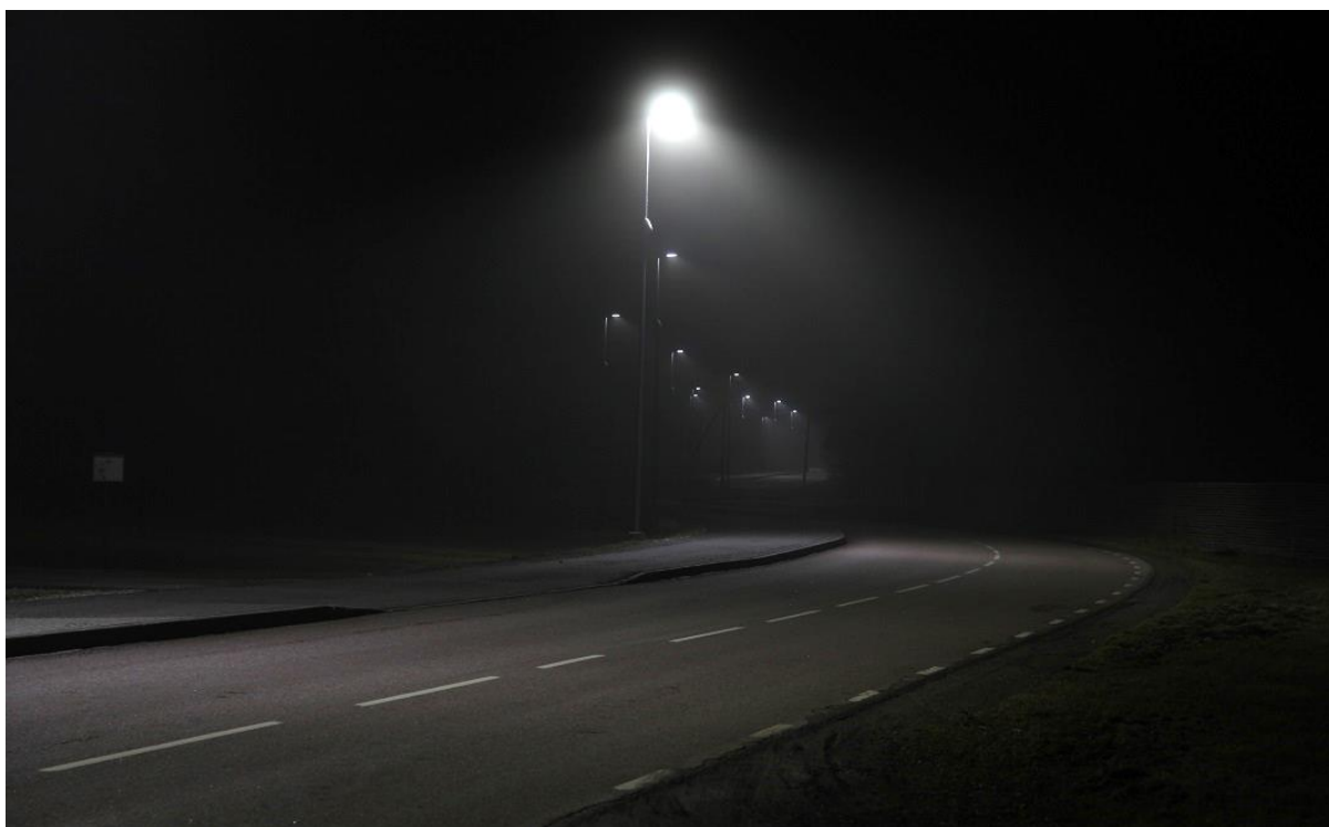
Foto 8. Leppneeme teel kasutatav radarjuhtimissüsteem loob täiendavat säästu. Esiplaanil valgustid 80% võimsusega töötamas, tagaplaanil 20% võimsus (kui liiklejad ei ole)
