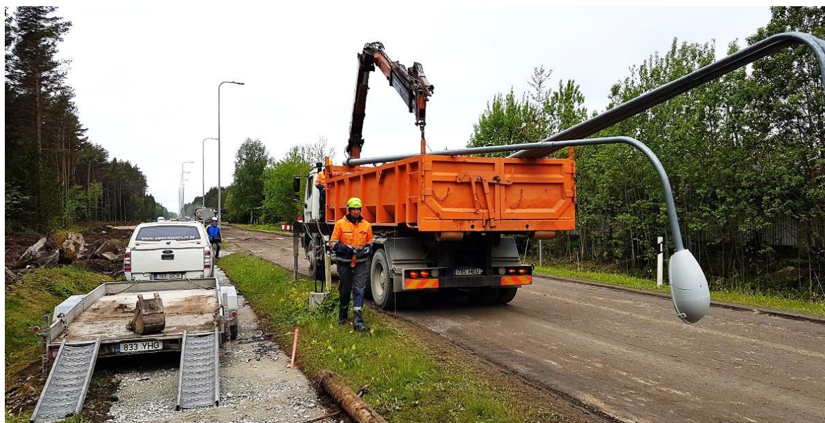
Foto 1. Vanade naatriumvalgustite demonteerimine Reinu teel 2019. aastal
