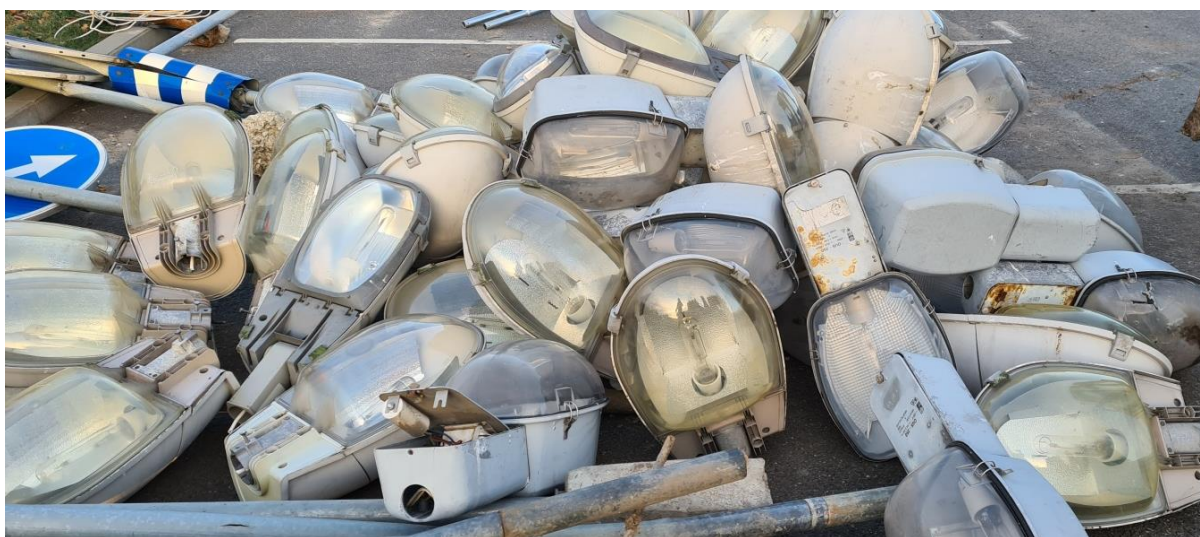
Foto 22. LED II projekti raames välja vahetatud amortiseerunud naatriumvalgustid
