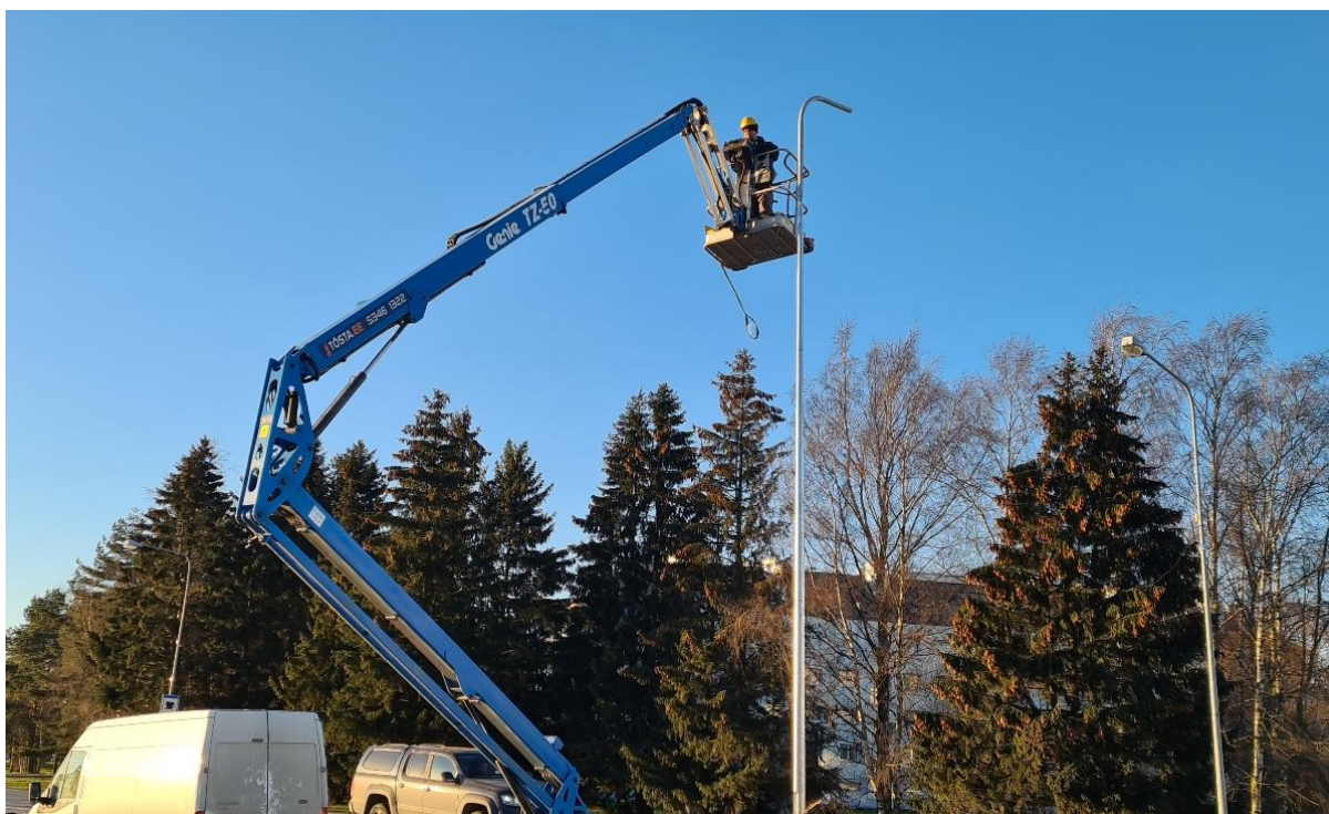
Foto 9. LED II projekti raames uute LED valgustite panek Haabneemes
