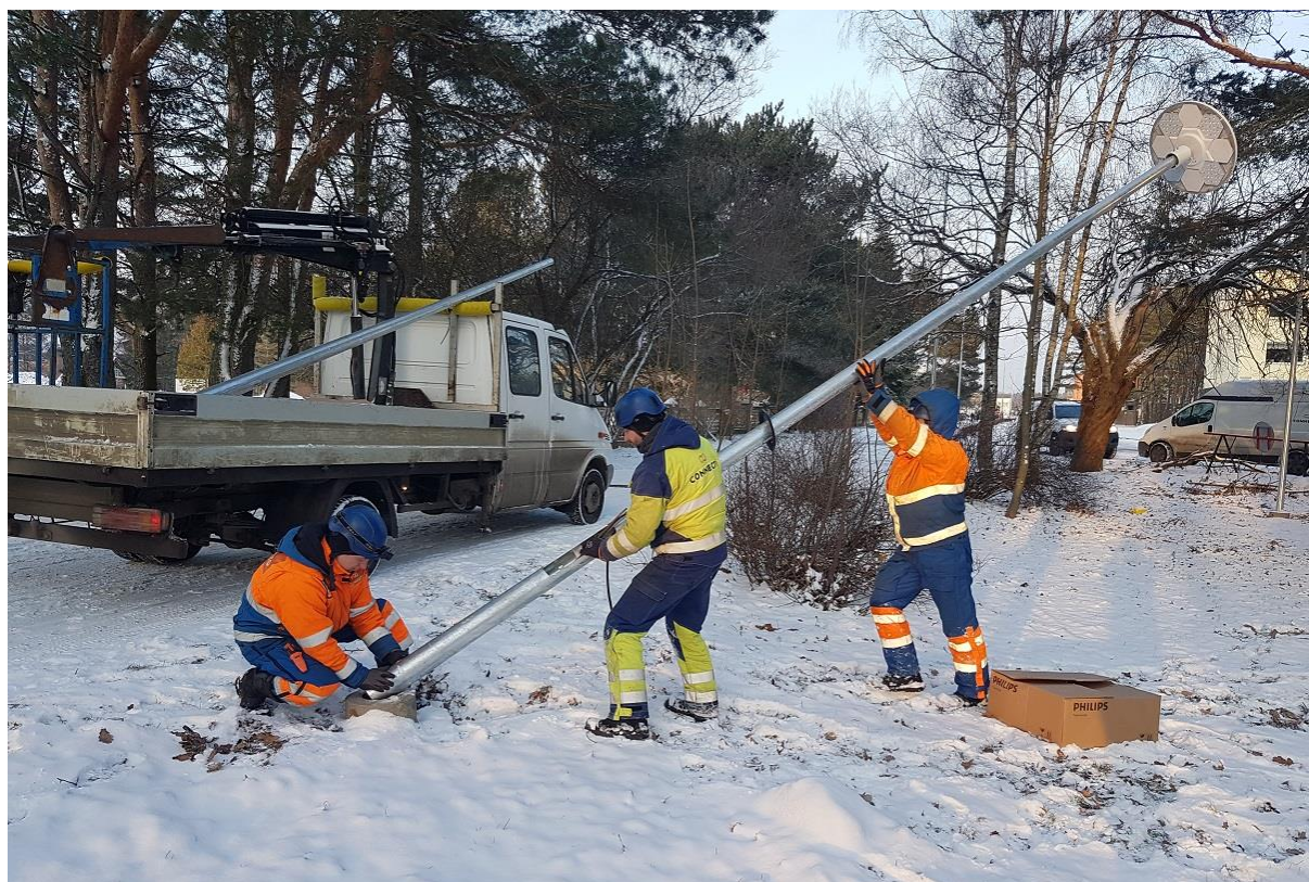
Foto 2. Uute LED valgustite panek Haabneemes amortiseerunud valgustite asemele 2019 talvel
