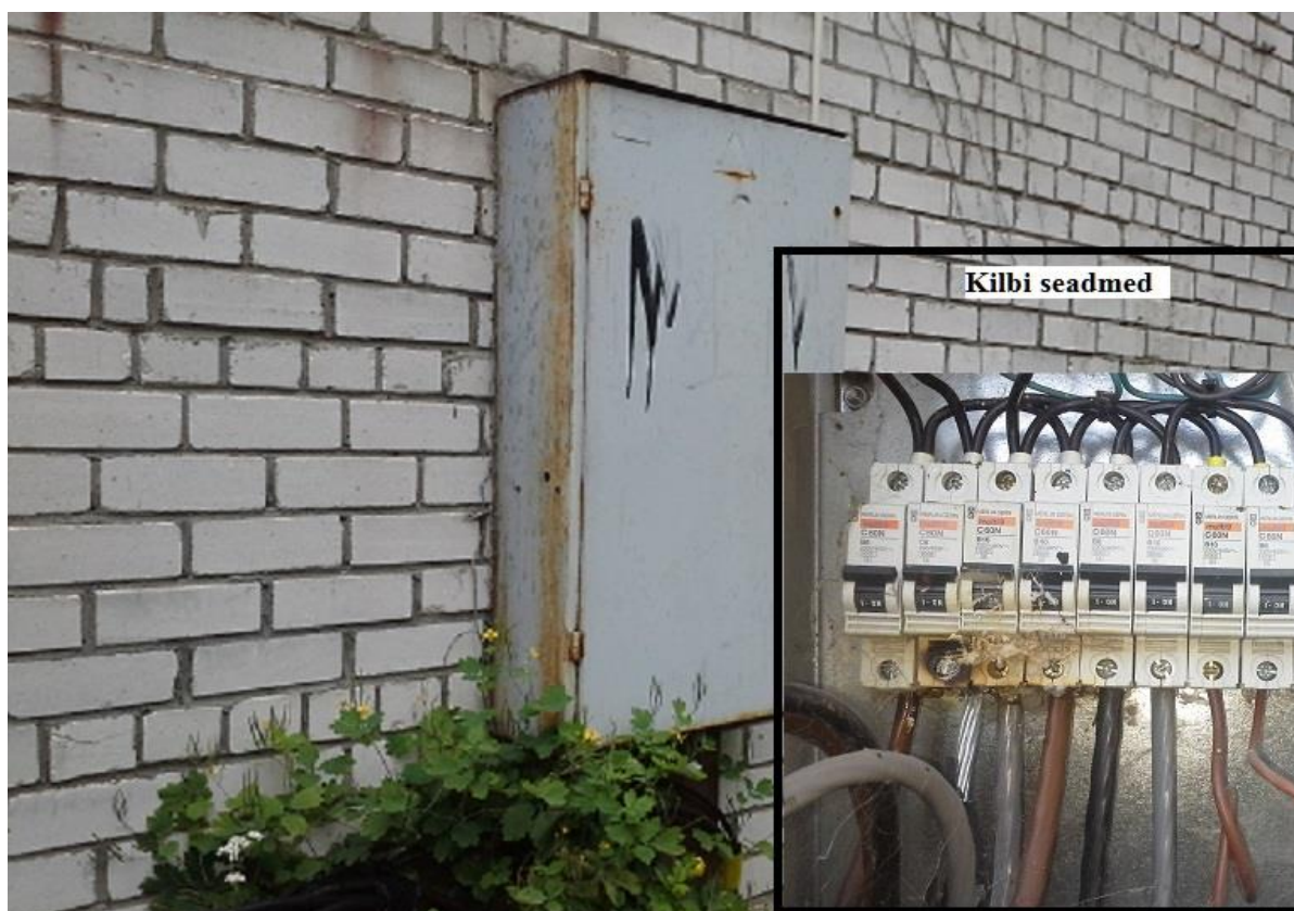
Foto 13. Näide amortiseerunud ja keskkonnaoludele mittevastavast tänavavalgustuskilbist
