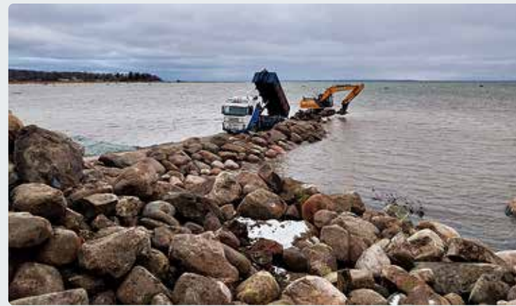
Filtratsioonikihi paigaldamine. Foto: Raul Ilisson
