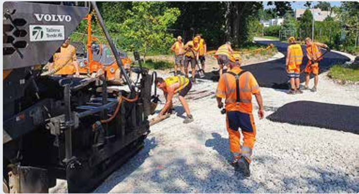
Drenasfaldi mahapanek. Foto: Alar Mik
