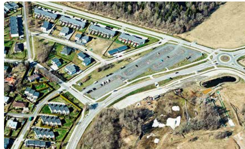
Busside seisuplats rajatakse Hundi tee 31 kinnistule. Foto: Maa- ja Ruumiamet
