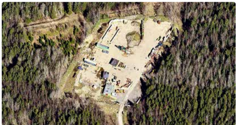
Vaade Komposti kinnistule. Foto: Maa-ameti kaldenurgafoto
