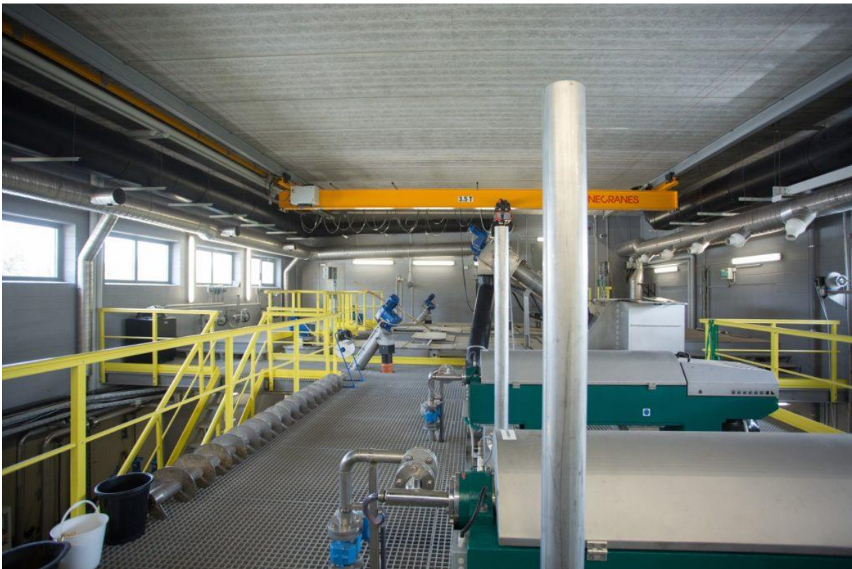
Foto 5-5 Puhasti tsentrifuugid mudatähtsuseks, tagaplaanil automaatsõre
