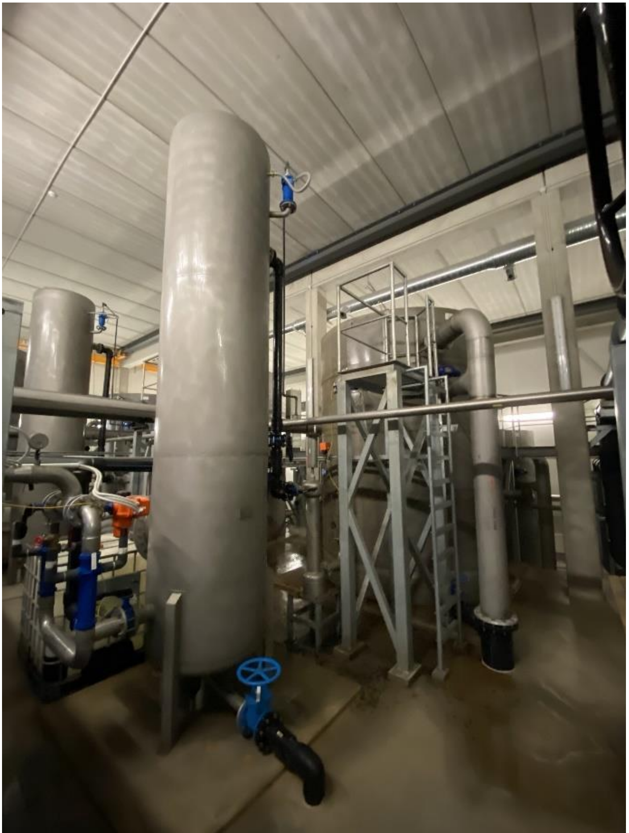
Foto 4-4 Viimsi veetöötusjaama tehnoloogine osa, filtrid
