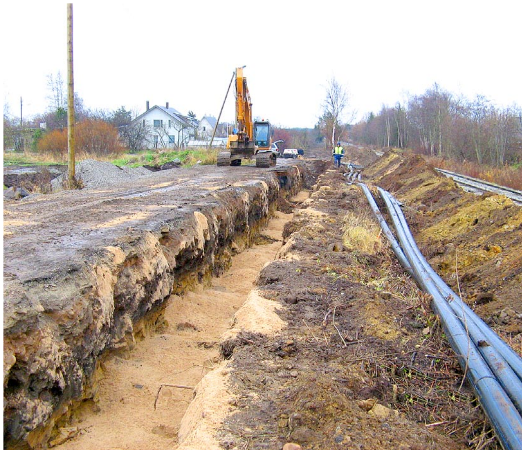
Kanalisatsioonitorustiku rajamine on mahukas töö.
